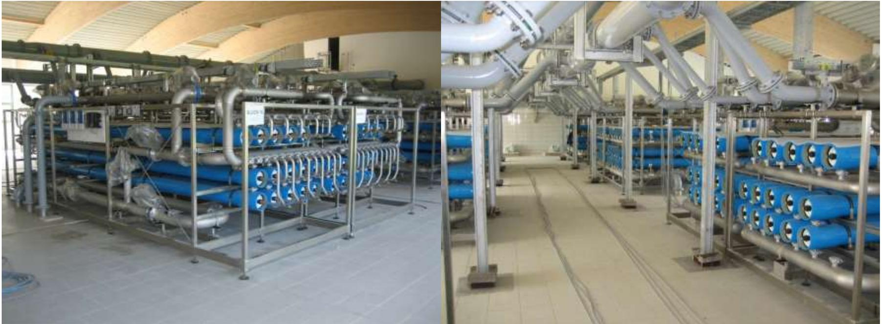
Stadtwerke Dinslaken, Wasserwerk Löhnen, Nanofiltration 1.100 m<sup>3</sup>/h
