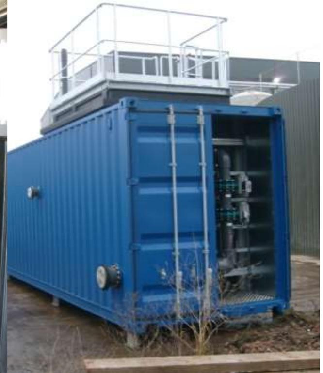
GE Water + Process, Membranbioreaktor im Container, 2x 15 m<sup>3</sup>/h
