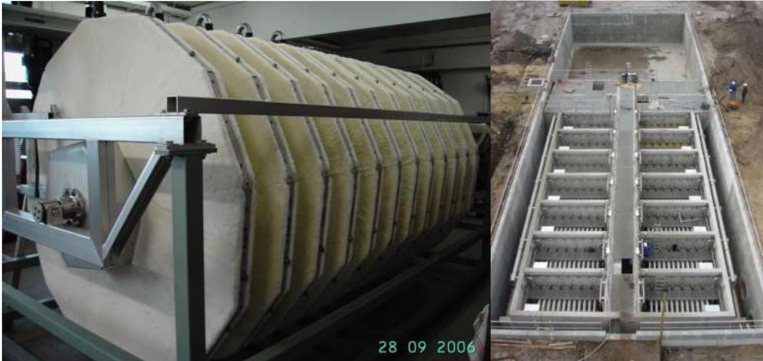
OOWV Kläranlage Oldenburg, 14 Tuchfiltereinheiten mit Polstoff, 5.800 m<sup>3</sup>/h
